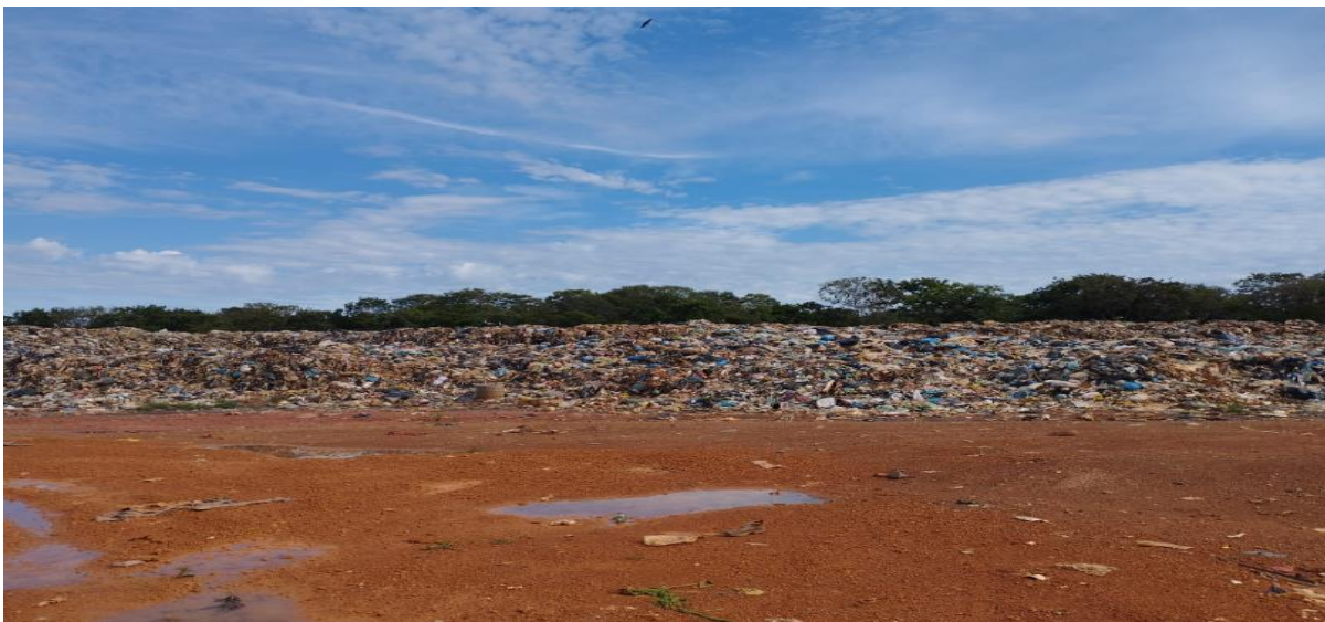
Figura 23 -Vala de Resíduos Sólidos Domésticos - RSD ativa: falta de compactação e cobertura, observa-se a ineficiência da operação.
