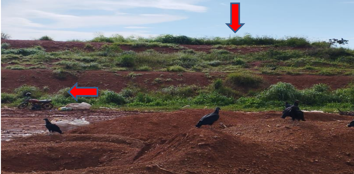
Figura 26 – Vala de RSD Desativada. Falta de placas de encerramento da vala, manutenção e limpeza das mesmas. Presença de moto dos catadores, afirmando a falta de controle da guarita e da manutenção das
