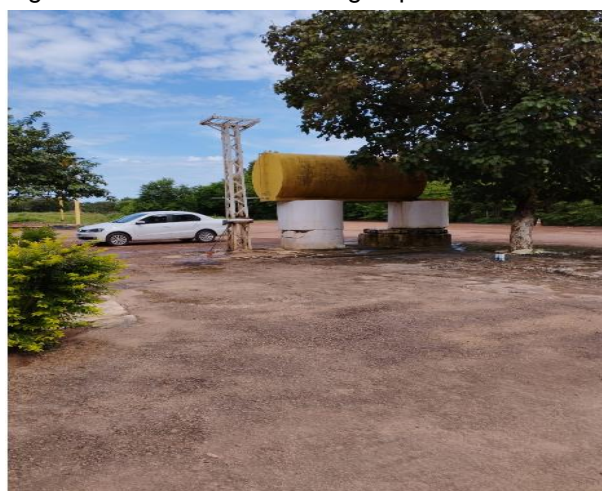
Figura 8 – Reservatório de água para consumo dos funcionários
