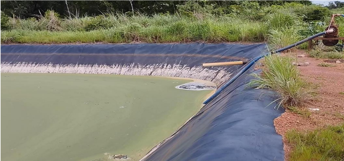
Figura 27 – Lagoa de Chorume ativa - Falta de manutenção no entorno da lagoa, presença de uma bomba onde realizam o bombeamento do mesmo para a vala RSD. Observa-se que a vazão do líquido é pequeno em relação à quantidade de resíduos depositados e chorume encontrado na vala de RSD, afirmando a ineficiência do sistema operacional da vala, na captação e drenagem do mesmo.
