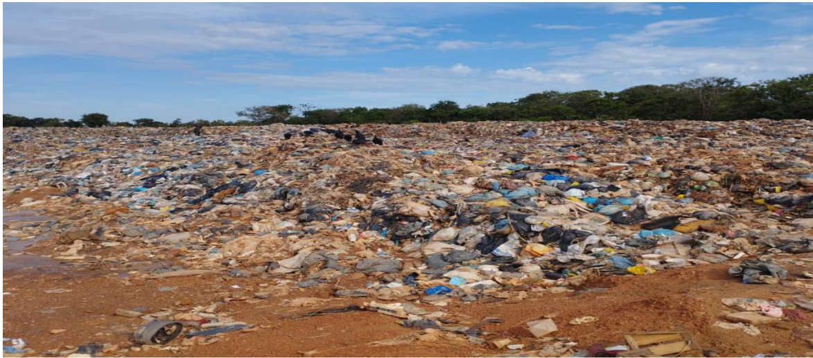
Figura 30 - Vala de RSD, presença de urubus, falta de cobrimento.
