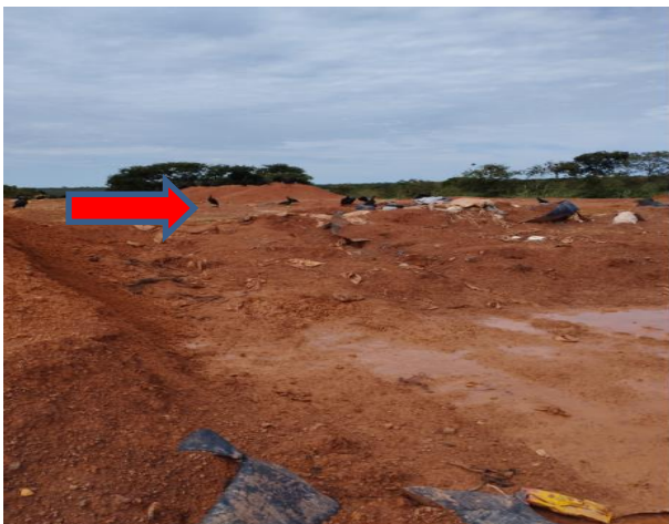
Figura 15 – Vala de Zoonose. Observa-se grande deficiência na operação da vala como o uso, descarte e cobertura e presença de urubu .
